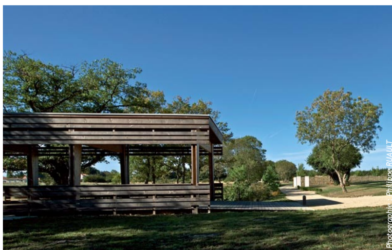
Le pont couvert enjamant le talweg.
