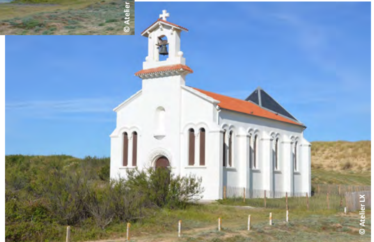
▲ La chapelle après restauration
