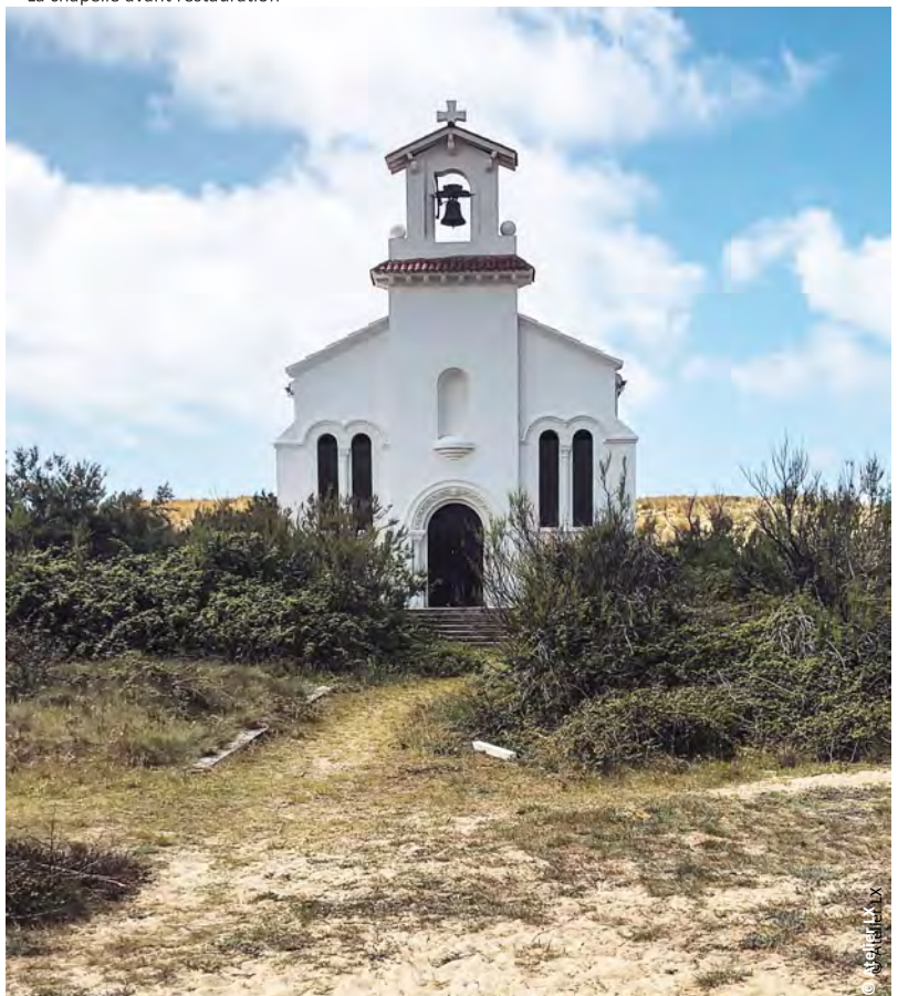
▲ La chapelle après restauration
