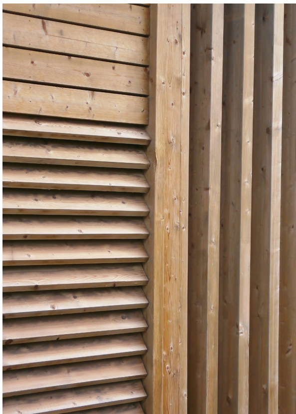
▲ Détail du bardage bois en pin maritime
