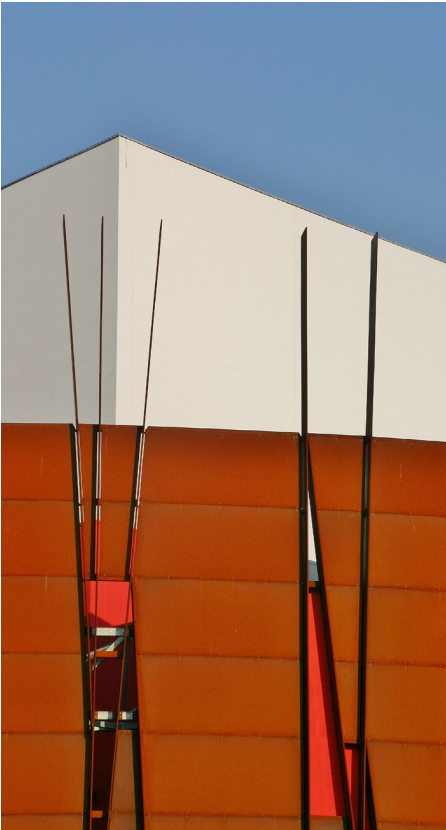
▲ Détail sur l'enveloppe en acier corten
