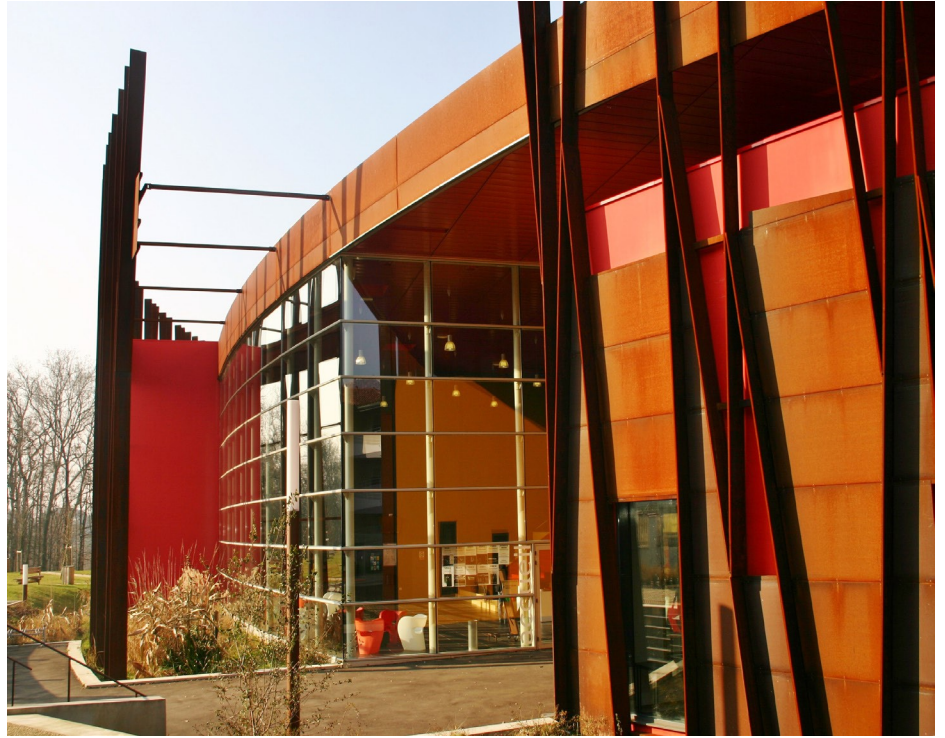
▲ Vue sur le hall d'accueil entièrement vitré
