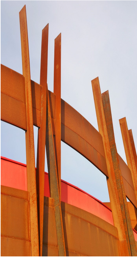
▲ Détail sur l'enveloppe en acier corten
