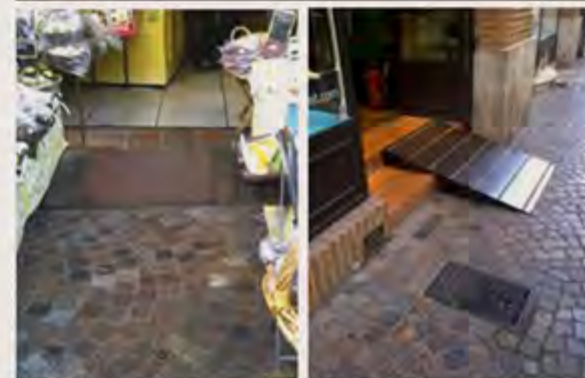
Exemple de systèmes de rampe amovible en bois et en métal.
