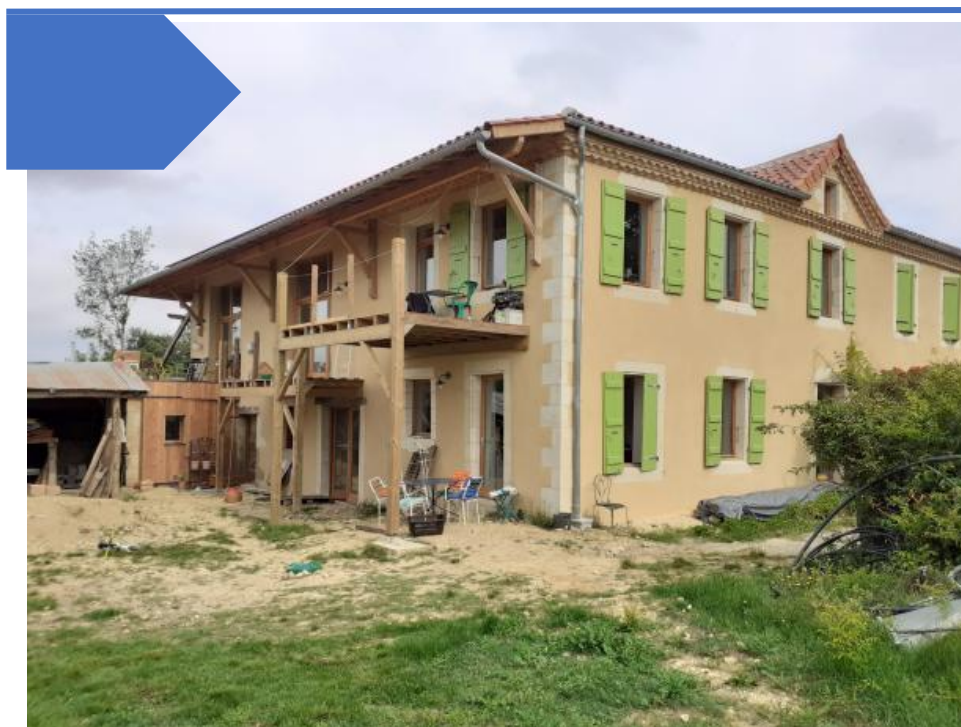
Le Penjat à Auch (32) « Une réhabilitation globale exemplaire »
