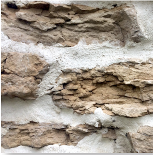
1. Des défaillances au niveau de l' enduit extérieur , des pierres ou des joints
