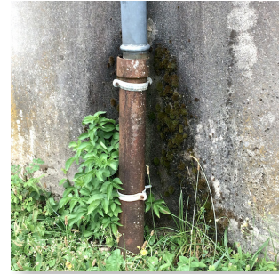
2. Une descente d'eau bouchée, déboîtée ou fendue, un regard cassé, une flaque stagnant contre la maison après la pluie...
