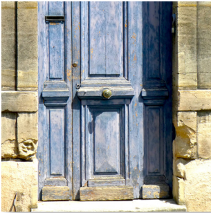
3. la dégradation des portes et des fenêtres par la perte d'étanchéité des joints ou la disparition de la peinture, l'absence d'un rejet d'eau*, le vieillissement de la menuiserie...
