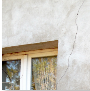
1. Des défaillances au niveau de l' enduit extérieur , des pierres ou des joints
