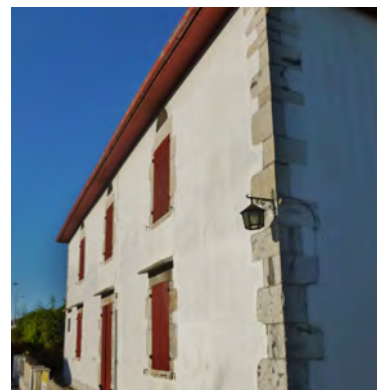
Maison Vienne et ses encadrements et chaînages d'angles en pierre apparente
