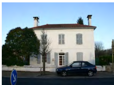
Monaco : volets gris pleins (rez-de-chaussée) et à persiennes (étage)
