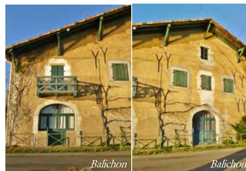
Détails : consoles de bois au niveau du toit, garde-corps au premier étage, portes à anse de panier\* en rez-de-chaussée.
