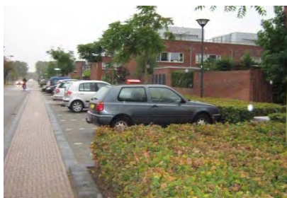
Végétalisation des espaces de stationnement pour limiter l'impact sur le cadre de vie et utilisation de revêtements de sol perméables afin de favoriser l'écoulement des eaux
