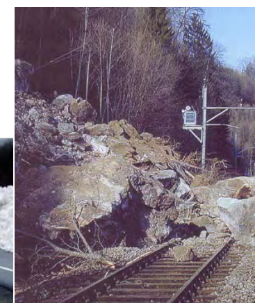
Chute de blocs dans l'Ain
