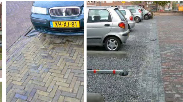
Végétalisation des espaces de stationnement pour limiter l'impact sur le cadre de vie et utilisation de revêtements de sol perméables afin de favoriser l'écoulement des eaux
