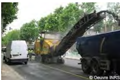
Réemploi des matériaux en place pour la réhabilitation des chaussées
