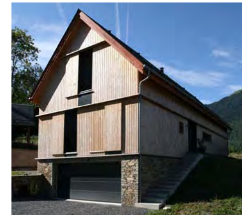
Maison à Montauban de Luchon certifiée labélisée BBC* - Prax Architectes.
