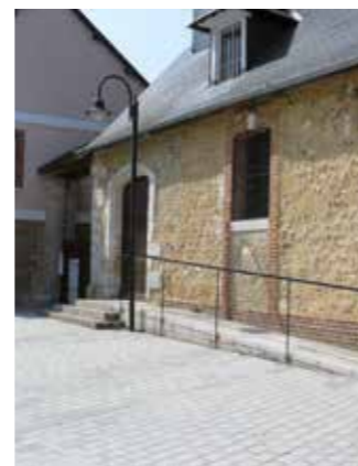
Rampe d'accès à Roncherolles-sur-le-Vivier, François Mirc architecte du patrimoine
