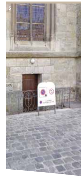
5 Signalétique mal placée, source de pollution visuelle
