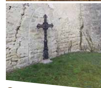
6 Travaux de mise à nu des fondations de l'édifice
